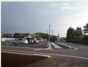
完成した柏崎インターバス停近くの駐車場
